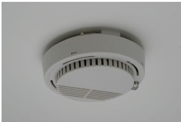
Figure 16.1.1: Smoke Detector. (CC SA -BY 3.0; Tumi-1983).
